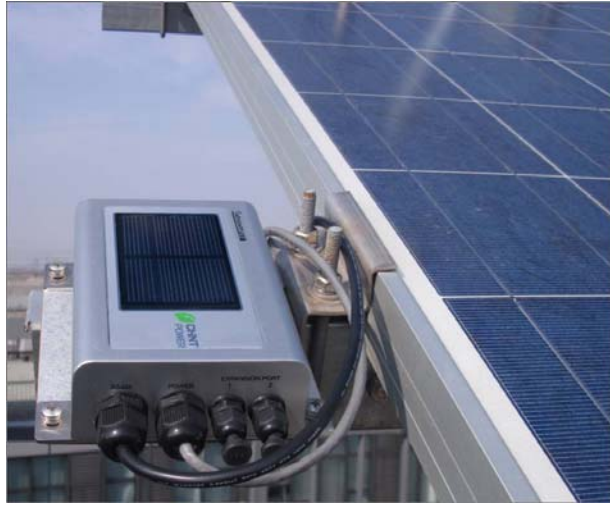
图 3-13 安装在电池板支架上
