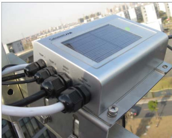
图 3-11 安装在斜撑梁上
